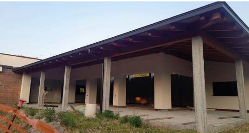
Il centro polivalente dove si attendono i lavori di completamento
